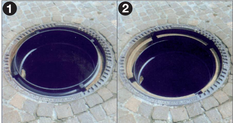
3. Ajuster la cartouche avec le côté plat vers l'échelle de montée.
